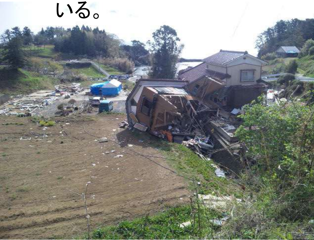
↑ 津波でなぎ倒された家
